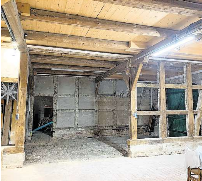
Auch der dritte Gang der Pfarrscheune ist bald nutzbar. Um die Kosten für die Arbeiten zu decken, wird der Weg über eine Lotterie eingeschlagen. Foto: privat
