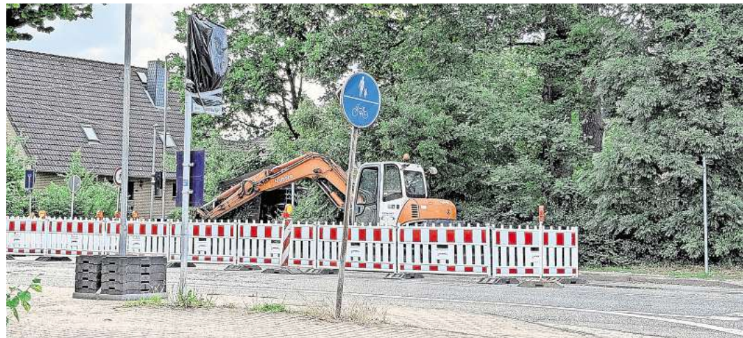
Es wird gebaut.
