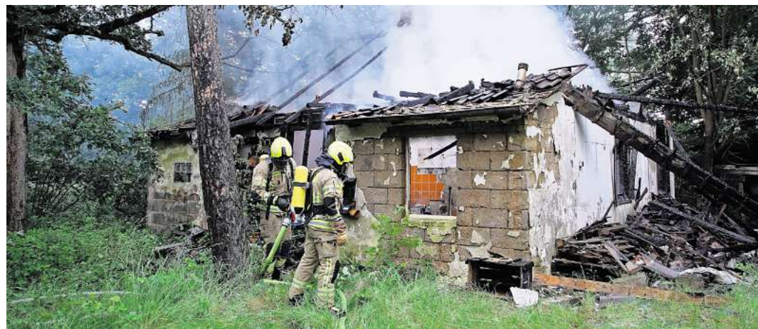
Asbestverseucht: Das alte Haus brannte lichterloh.
