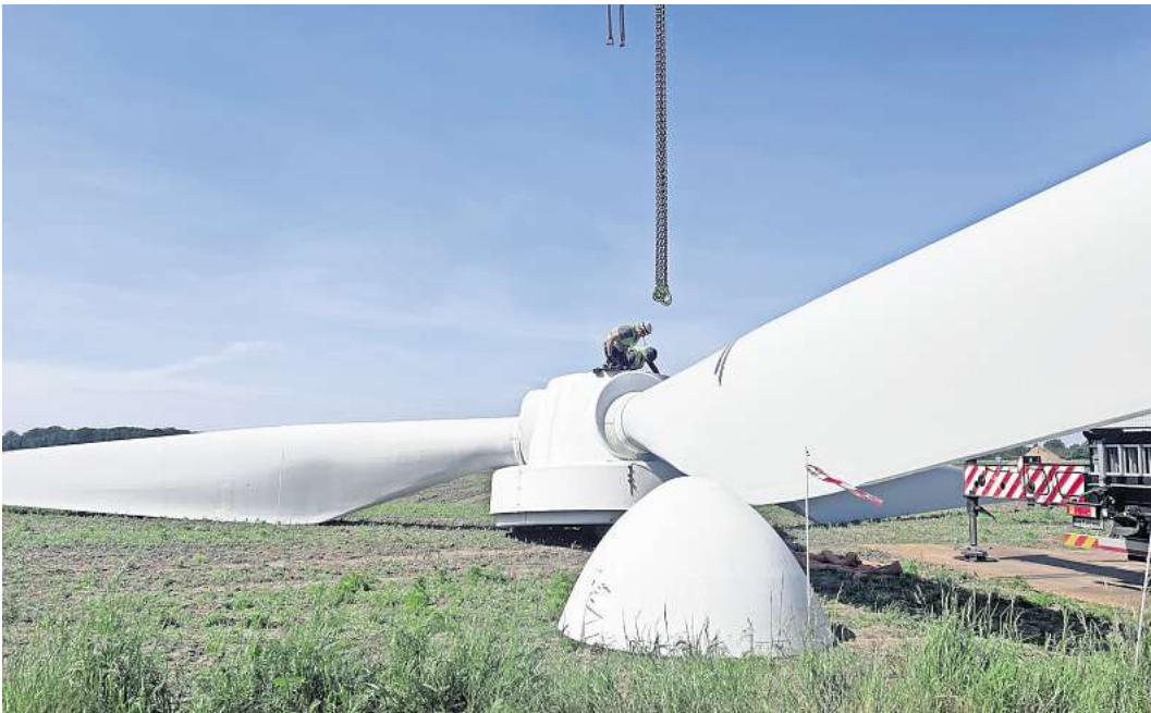
Schrauben werden gelöst: Nun werden die Rotorblätter abgebaut.
