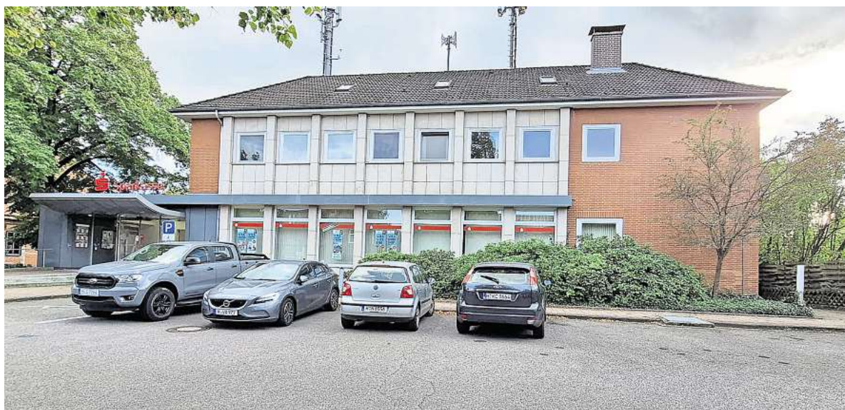
Wenn die notwendigen Arbeiten erledigt sind, kann das Heimatmuseum in Bissendorf in die neuen Räumlichkeiten im ehemaligen Sparkassengebäude einziehen. Foto: Gabriela Vrobel
