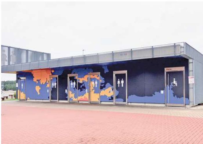
Außen poppig - innen mangelhaft: Die Sanitäranlagen des Rastplatzes Osterriehe. Foto: Reimann
