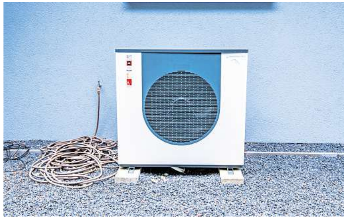
Moderne Wärmepumpen sind leiser als früher: Mit unter 50 Dezibel arbeiten sie so leise wie ein Geschirrspüler.
