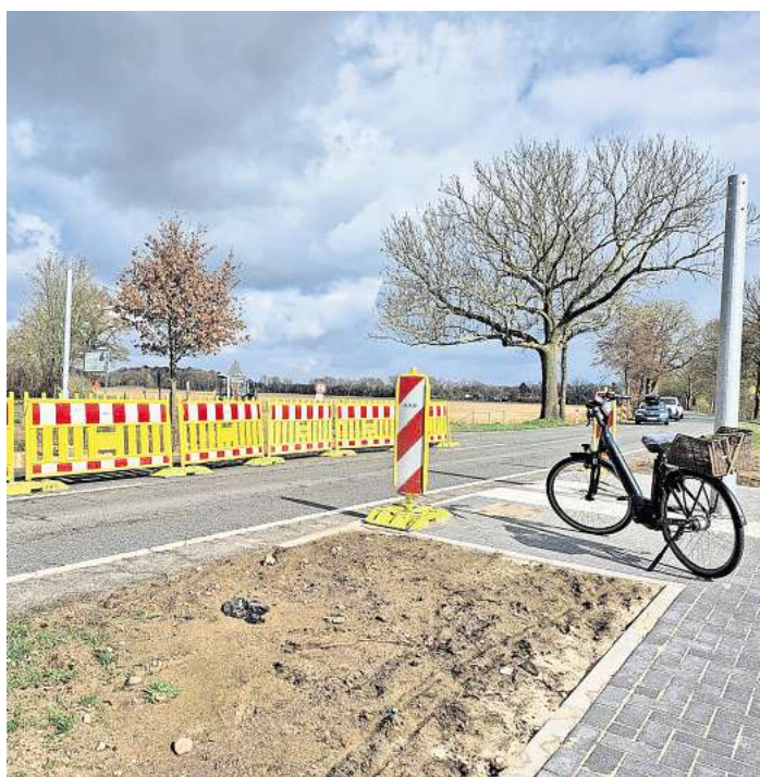
Hier wird für mehr Sicherheit gesorgt.
