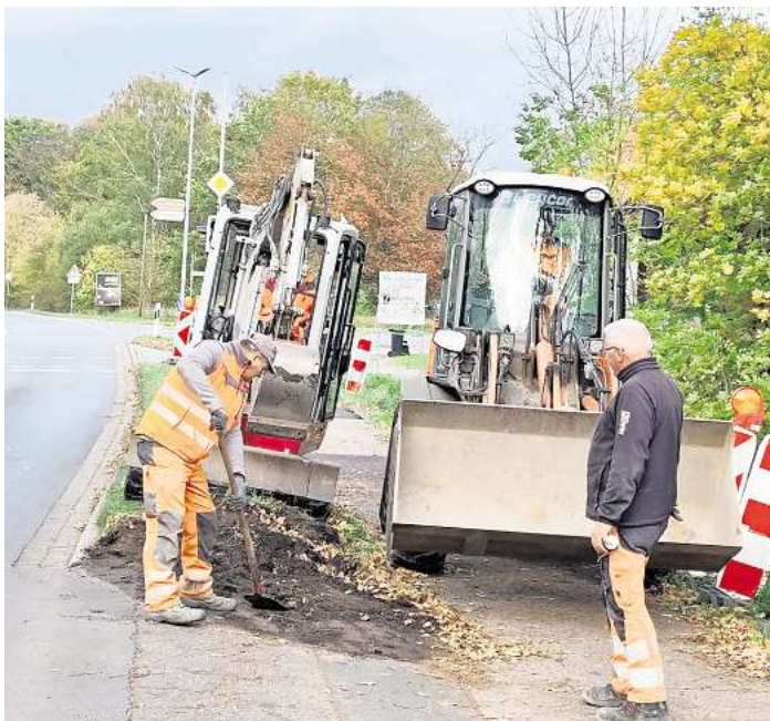
Viel Platz nötig: In Resse bereiten Tiefbauer die Straße für das ausgemusterte Flugzeug vor. Foto: Dirk v. Werder
