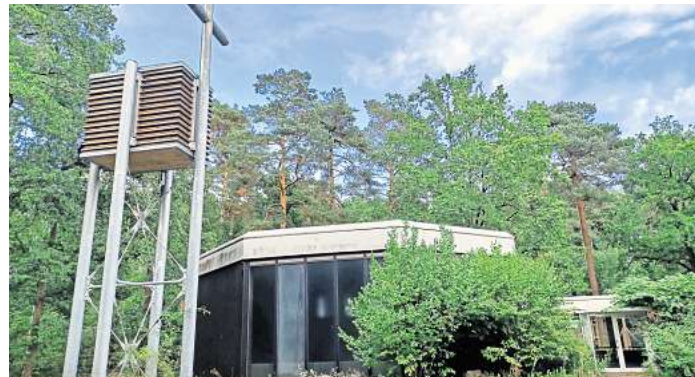
Außer Betrieb: Die entwidmete Christophoruskirche - im Vordergrund der Turm, der nun demontiert und in Bissendorf neu aufgebaut werden soll. Foto: privat
