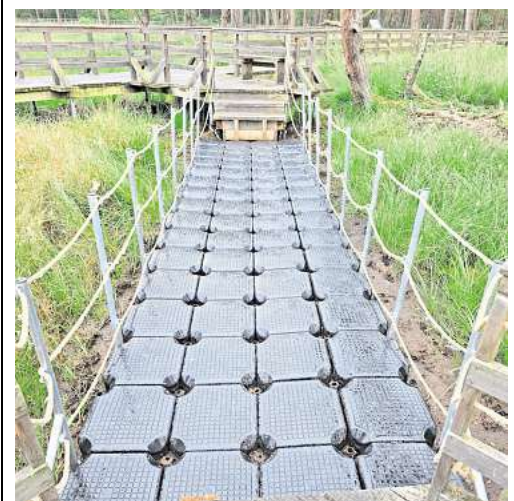
Die neue Schwinggrasensbrücke.
