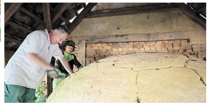
Harald Platte und Jona Demera bessern die Risse des großen Backofens aus.
