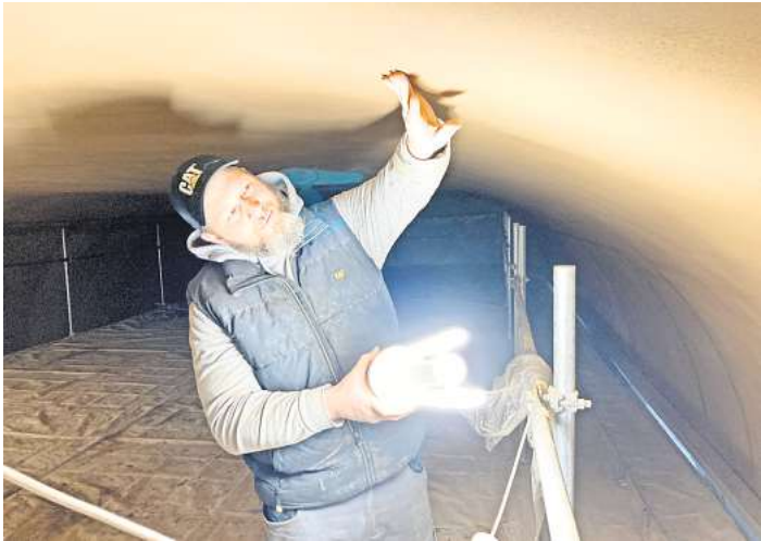
Er ist zufrieden: Björn Beck prüft in der Tonnendecke von St. Martini die Putzschicht, die aktuell trocknen muss.
