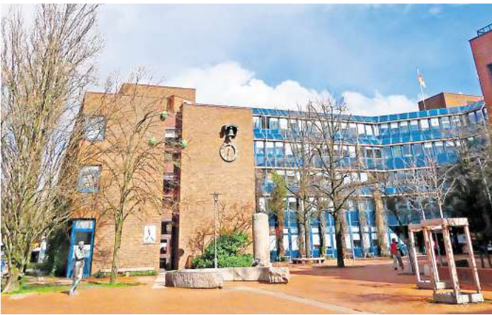
Rathaus Langenhagen - Südseite.
