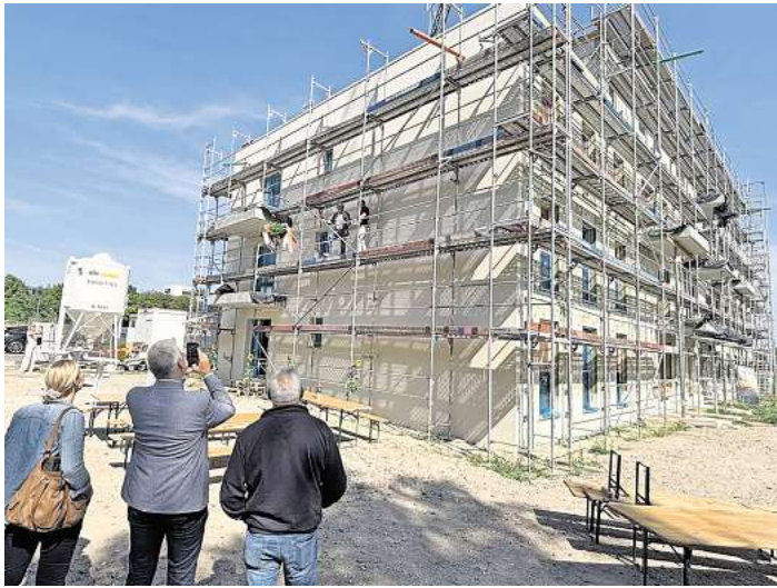
Im Rohbau: Das ist das Mehrfamilienhaus an der Dieter-Liedtke-Straße.
