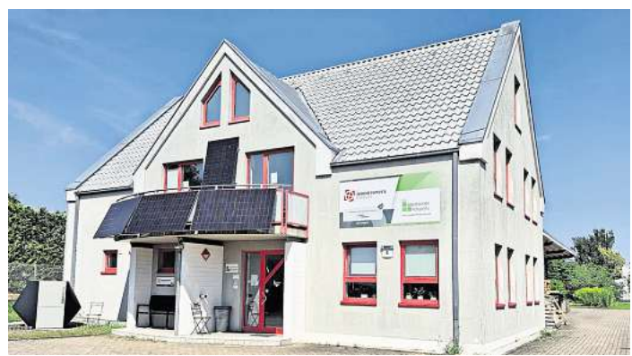
Im Gewerbegebiet an der Industrieweg in Mellendorf ist der Firmensitz des „Wärmepumpenpartners“ zu finden.
