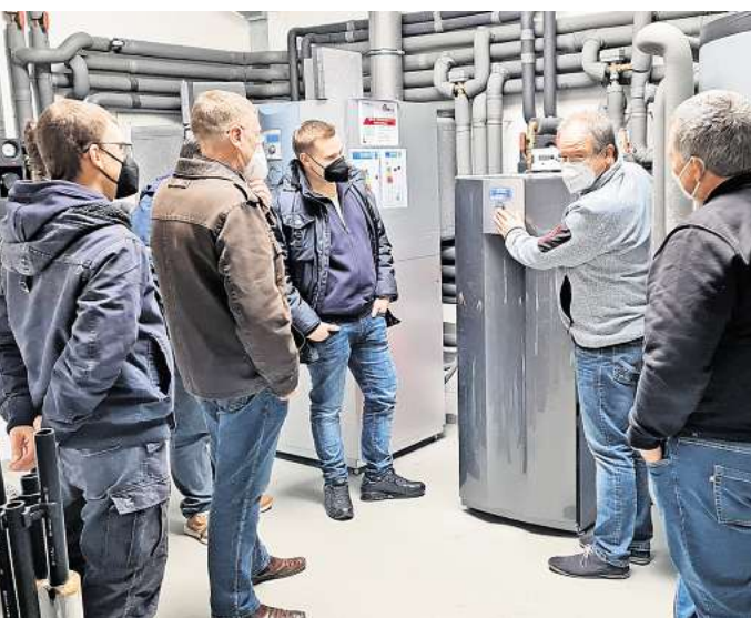
Auch das gehört zu den Leistungen, die Daniel Stanitzok als Wärmepumpenpartner erfüllt, die Information und Schulung von Installateuren und Technikern.
