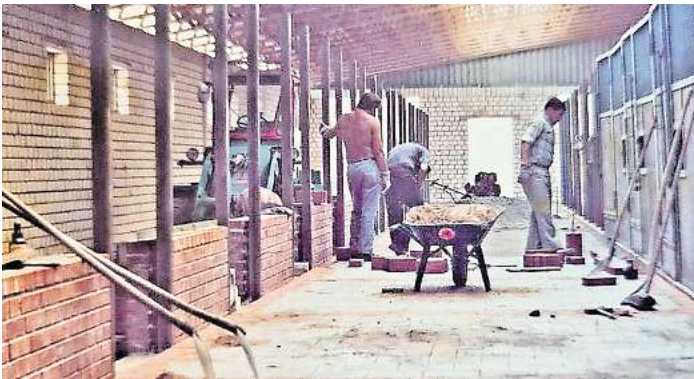
Der Bau der eigenen Halle war ein wichtiger Entwicklungsschritt.
