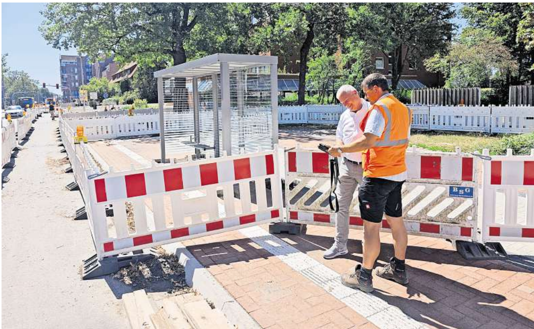
Schauen sich die Baustelle kurz vor dem Abschluss an: Bürgermeister Mirko Heuer (CDU) und Andreas Kästner aus der Abteilung Verkehr und Straße. Foto: Josefine Battermann
