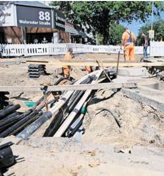
Letzte Arbeiten an der Walsroder Straße: Mitte September sollen die Bauarbeiten abgeschlossen sein. Foto: Josefine Battermann
