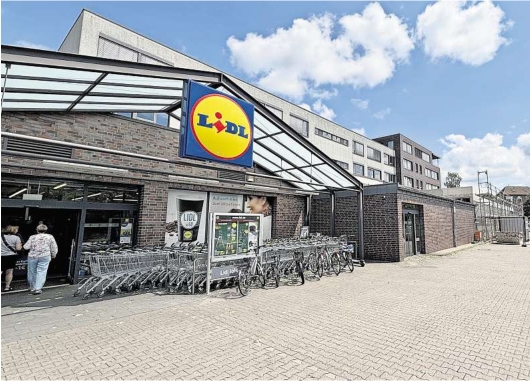
Sie expandieren: Lidl erweitert sich am Straßburger Platz in Langenhagen. Im Vordergrund ist der Haupteingang zu sehen, daneben der Bereich mit der Leergutannahme. Dort grenzt der Anbau an.
