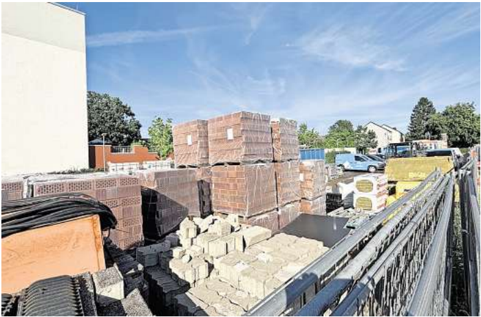
Noch viel zu tun: Am Rande des Bahnhofs Langenhagen-Mitte ist jede Menge Material gelagert, das für die noch bis ins Jahr 2027 andauernde Sanierung benötigt wird.
