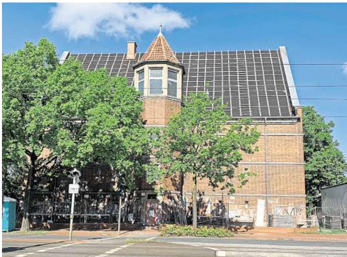
Arbeiten beginnen: Vor dem Hochbunker an der Walsroder Straße steht nun ein Bauzaun um das Gebäude und Arbeiter bauen auch das Gerüst vor der Fassade auf. Foto: Katerina Jarolim-Vormeier
