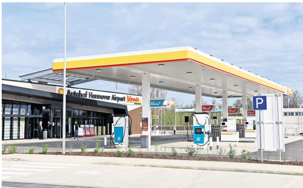
Mehr als eine Tankstelle: Der Bau des Autohofs am Flughafen in Langenhagen hat rund 30 Millionen Euro gekostet. Foto: Gerko Naumann
