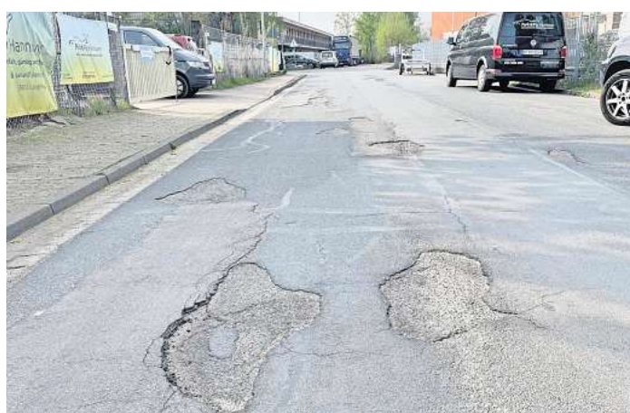
Eine Zufahrt zu den Grundstücken ist im Mühlenfeld während der Bauarbeiten nicht möglich. Foto: Oliver Krebs
