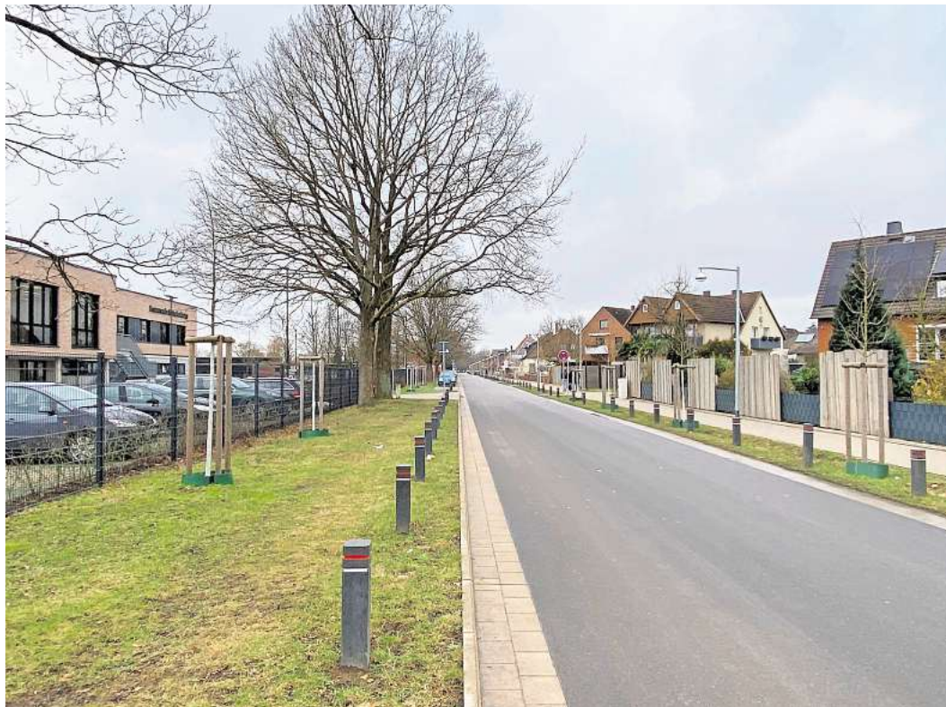
Der Stadtweg in Engelbostel ist gerade neu ausgebaut worden: Anwohner kritisieren, dass Autofahrer viel zu schnell die Straße passieren - und das sieben Tage die Woche. Foto: Katerina Jarolim-Vormeier
