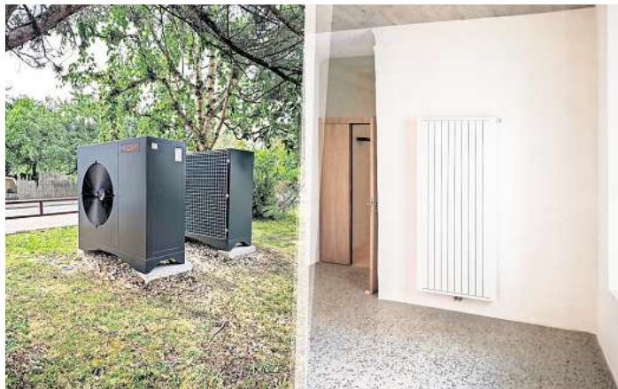
Der Aluminium-Heizkörper ist speziell für den Betrieb mit geringen Vorlauf-temperaturen von maximal 45 Grad Celsius konzipiert und arbeitet komplett ohne elektrischen Motor, wie es üblicherweise bei Wärmepumpen-Heizkörpern der Fall ist.
