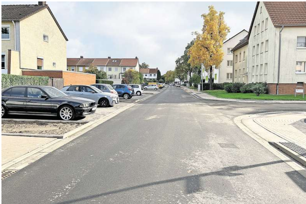
Die Bauarbeiten am Allerweg sind erfolgreich abgeschlossen worden.
