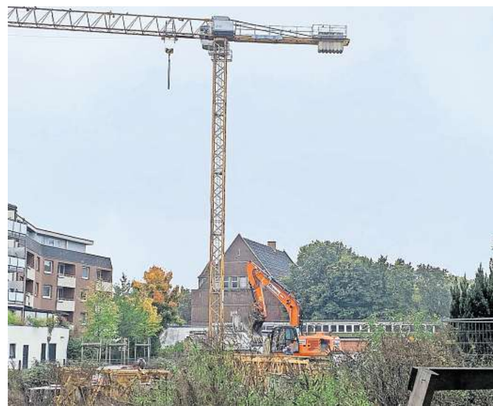
Bewegung auf der Baustelle: Nach langem Stillstand starten die Bauarbeiten an der Kastanienallee, wo 59 Wohnungen errichtet werden sollen.
