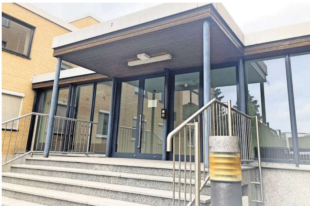
Hier geht niemand mehr rein oder raus: Das ist der Eingang der ehemaligen Schornsteinfegerschule in Langenhagen. Foto: Stephan Hartung
