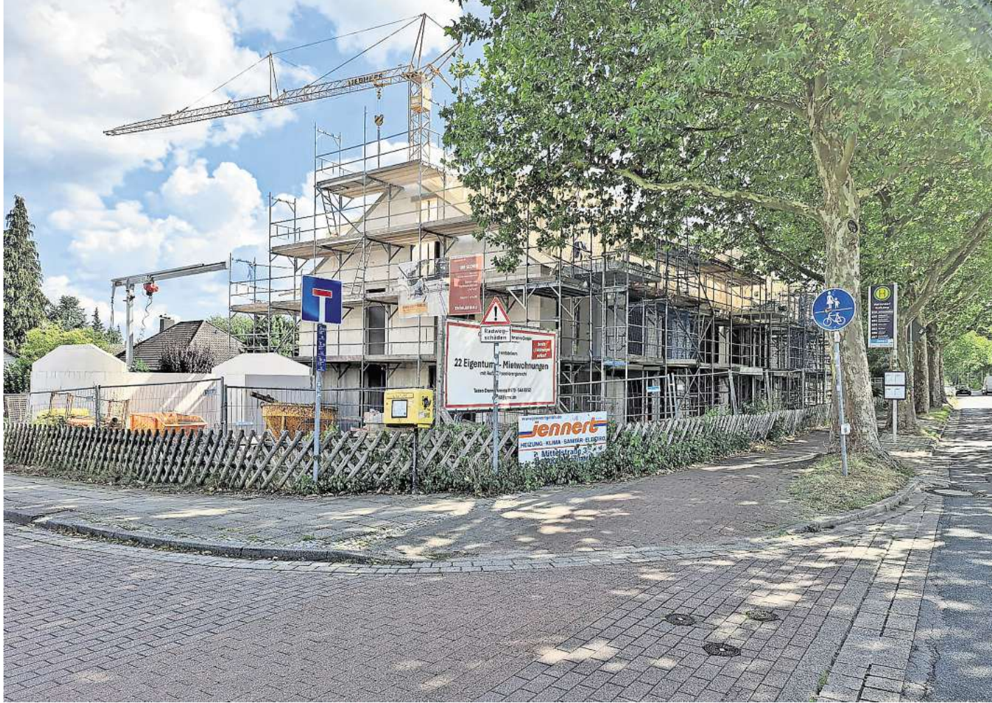
Der Gebäudekomplex ist an der Schaumburger Straße gelegen, direkt davor starten mehrere Buslinien. Das kleine Gebäude im Vordergrund dient als Fahrradhaus. Foto: Gabriela Vrobel
