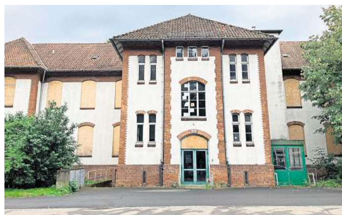
Haus 10 im Stadtpark: Die Stadt Langenhagen will das Gebäude verkaufen.
