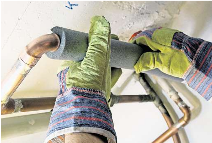
Die Rohrisolierung kann den Energieverbrauch der Heizung deutlich reduzieren.
