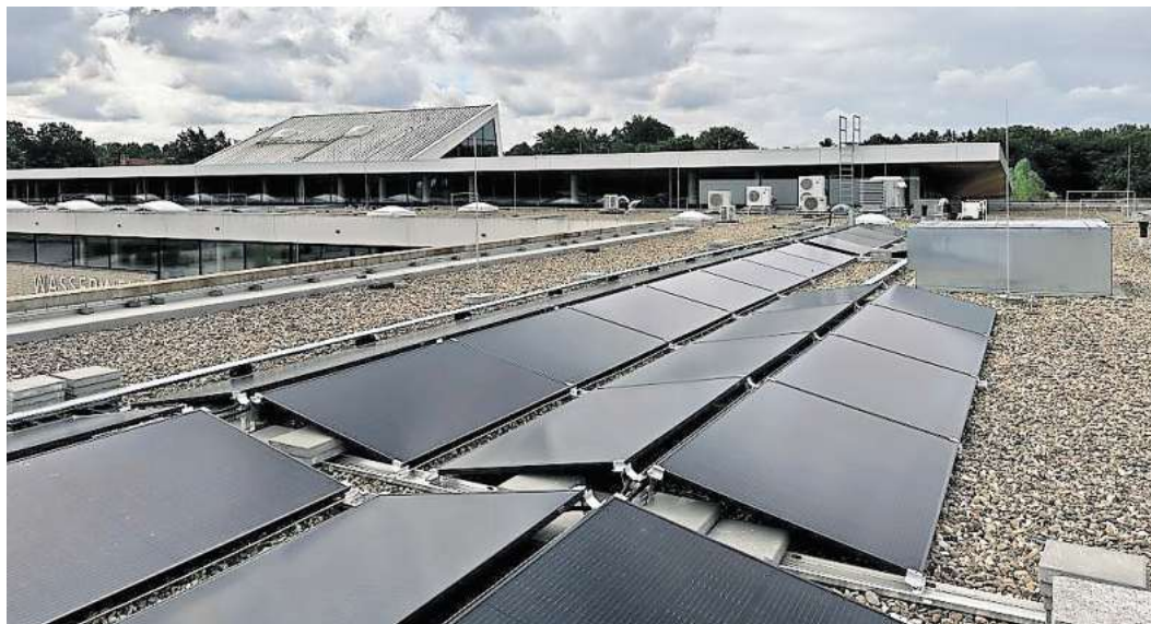
Blick aufs Schwimmbaddach: EPL hat auf der Wasserwelt Langenhagen insgesamt 240 Solarmodule installiert. Foto: EPL
