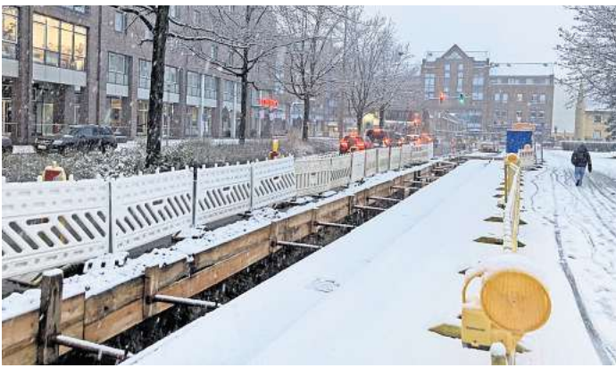
Einspurige Verkehrsführung: Das ist die Baustelle auf der Konrad-Adenauer-Straße. Am linken Bildrand ist die Stadtbibliothek zu sehen, im Hintergrund die Häuser an der Walsroder Straße 78/80 - an die die Fernwärmeleitungen angeschlossen werden.
