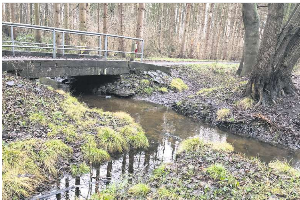
Ein kleiner Trick: Wegen des aufgeschütteten gegenläufigen Gefälles entwässert der Graben im oberen Bildabschnitt nur noch bei Starkregen, ansonsten bleibt das Wasser im Gelände. Foto: HAZ-Archiv
