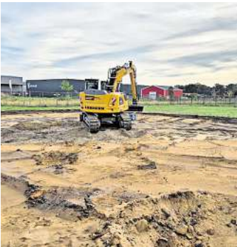
Auf einer Fläche von 4.479 entsteht etwa mittig zwischen Gailhof und Meitze das neue Feuerwehrhaus im Industriegebiet. Foto: Gabriela Vrobel
