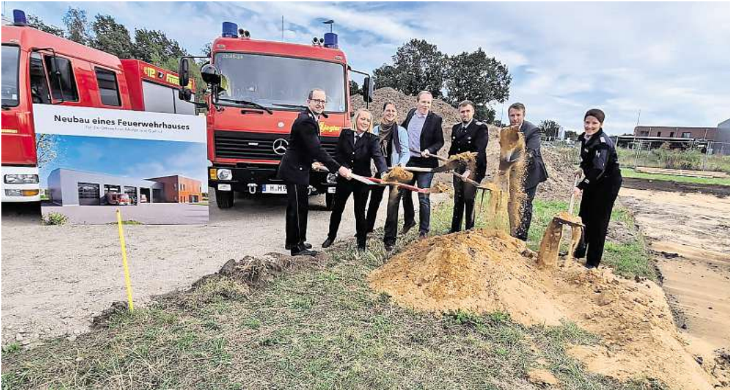
Sie sorgten für die ersten Spatenstiche für den ehrgeizigen Neubau des Feuerwehrhauses für Gailhof und Meitze: Philipp Linke (stellv. Ortsbrandmeister Gailhof), Annabelle Moeck (Ortsbrandmeisterin Gailhof), Bauleitern Dörthe Benecke, Florian Lübeck, Robert Wendt (Ortsbrandmeister Meitze), Helge Zychlinski und Wiebke Kracke (stellv. Gemeindebrandmeisterin) von links. Foto: Gabriela Vrobel
