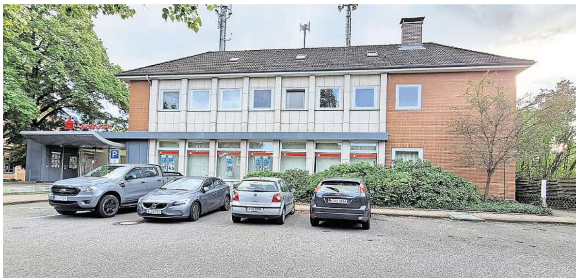
Wenn die notwendigen Arbeiten erledigt sind, kann das Heimatmuseum in Bissendorf in die neuen Räumlichkeiten im ehemaligen Sparkassengebäude einziehen. Foto: Gabriela Vrobel
