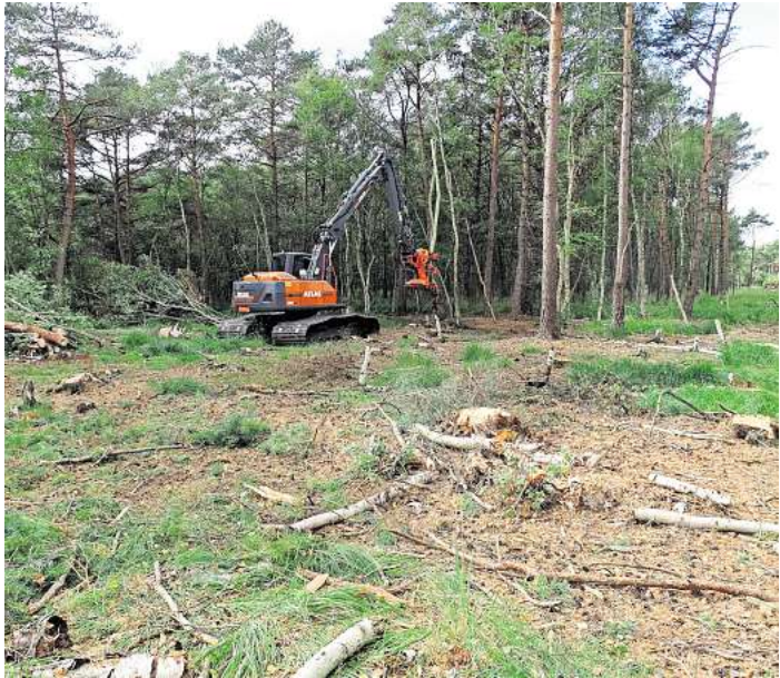
Das letzte Baufenster 2025/2026 wurde im Helstorfer Moor dafür genutzt, die Baurassen von Gehölz freizustellen und für die kommenden Erdbauarbeiten vorzubereiten.
