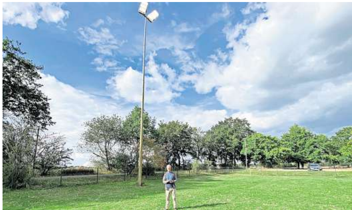
Energie sparen: Uwe Weißmann steuert die neuen LED-Flutlichter per Handy-App.
