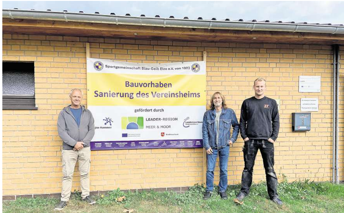
Projekt in Arbeit: Uwe Weißmann (von links), Dirk Bantelamm und Timon Dröge, Spartenleiter Fußball Jugend, der als Zimmerermeister viel Eigenarbeit in die Sanierung steckt, vor dem Baustellenschild.
