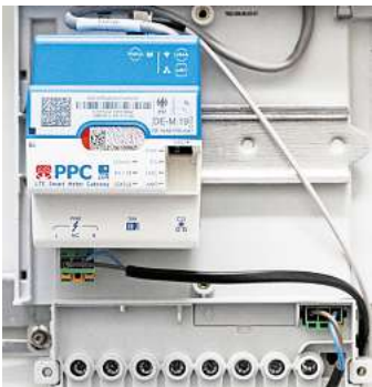
Smart Meter ermitteln den Stromverbrauch und können die erhobenen Daten direkt etwa an den Stromversorger oder den Netzbetreiber versenden. Foto: Markus Scholz/dpa
