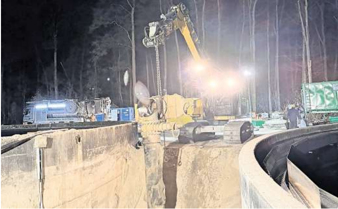
Das alte rausgetrennte Leitungsstück wird rausgehoben. Foto: Gemeinde Wedemark
