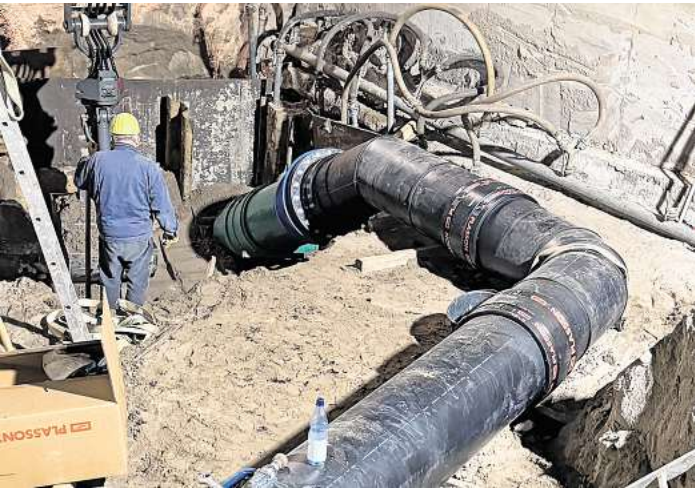
Die Leitung wird nach Erdarbeiten fertiggestellt.
