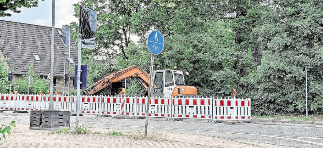
Es wird gebaut.
