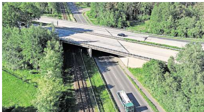
Die Brücke über Bahn und L190. Foto: Die Autobahn GmbH des Bundes
