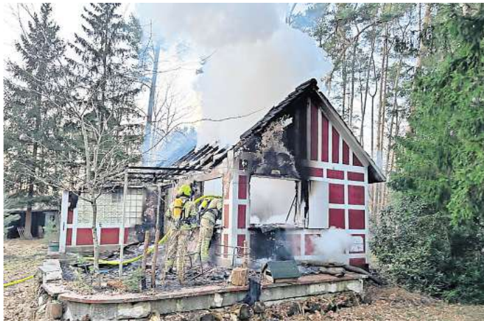
Haus in Brand in der Straße „Zur Wietze“. Foto: Feuerwehr Wedemark
