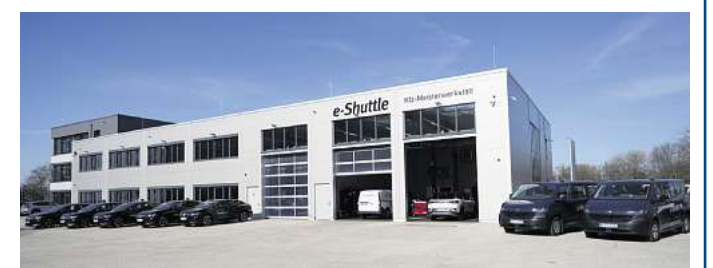
Die neue KFZ-Meisterwerkstatt direkt am Flughafen Hannover. (Foto: Ramin Faridi)
