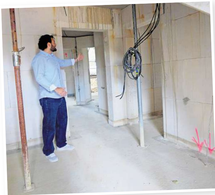
Es gibt drei Wohnungszuschnitte, die sich allesamt vom Standard abheben. Das gilt nicht nur für relativ breite Flure und Türrdurchgänge. Hier zeigt Vito Donnarumma eine Zweizimmer-Wohnung im Rohbau. Foto: Gabriela Vrobel
