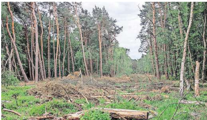
Bevorstehender Dammbau im Helstorfer Moor: Nach Entfernung des Holzes werden Verwallungen aus Torfboden aufgebaut, die das Regenwasser im Moor zurückhalten. Foto: Jens Fahning, NLWKN
