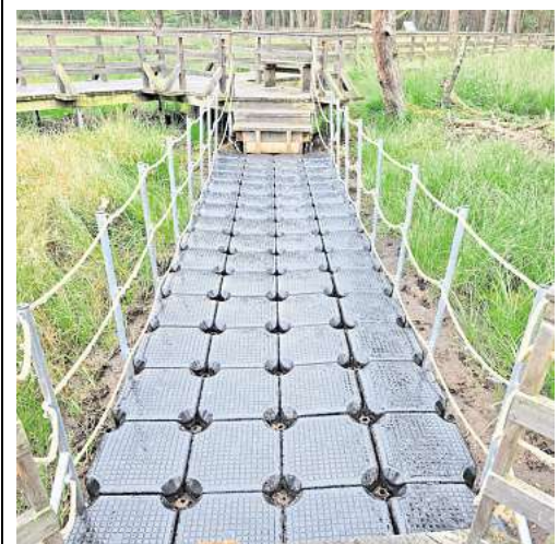
Die neue Schwinggrasbrücke.
