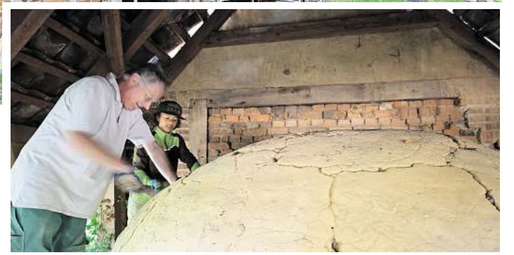
Harald Platte und Jona Demera bessern die Risse des großen Backofens aus.
