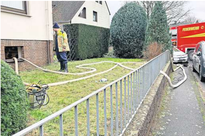
Hochwassereinsatz in Langenhagen: Der Keller eines Hauses wird von der Feuerwehr mit zwei Schläuchen leergepumpt.
