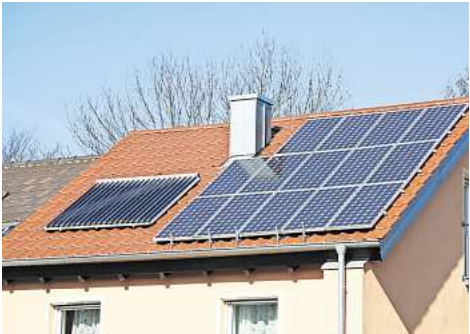
Solarthermie ergänzt im Bestand meist eine Öl- oder Gasheizung. Foto: Manfred X / Shutterstock 33603201_002623
