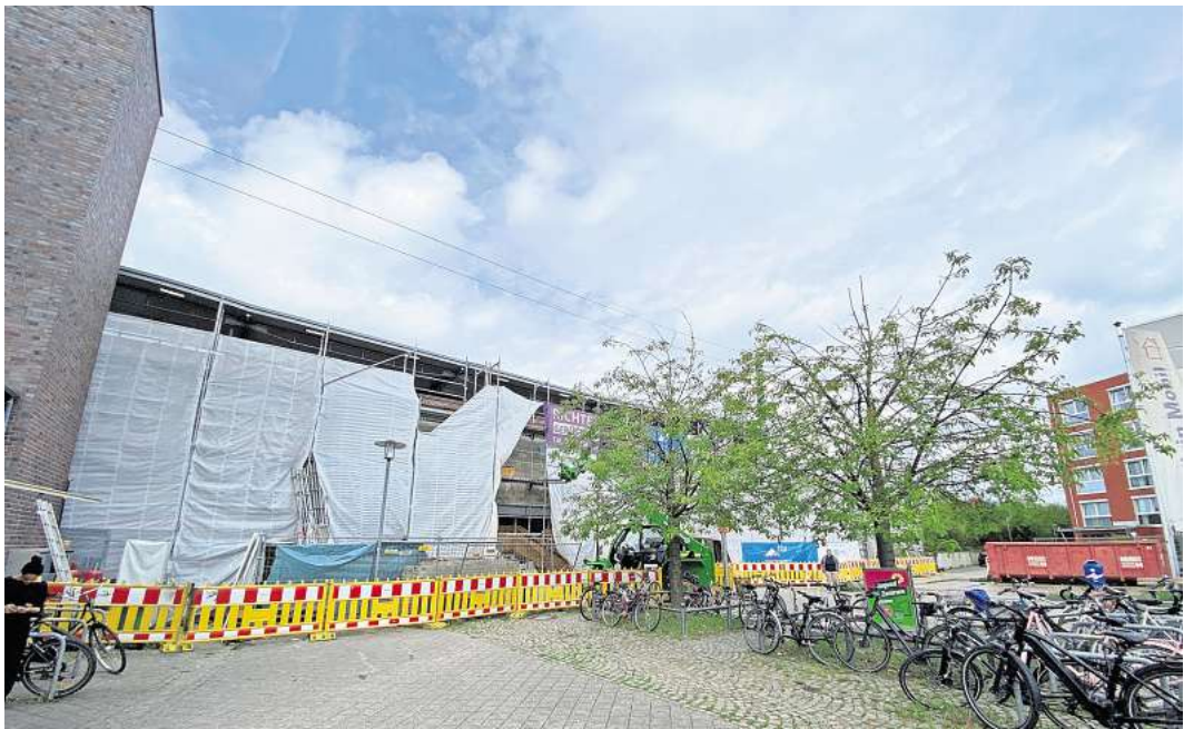
Verhüllung bleibt bis 2027: Solange erneuert die Bahn die Außenfassade der Station Langenhagen-Mitte. Foto: Katerina Jarolim-Vormeier
